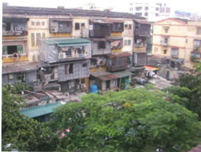
住棟背面の増築の様子
