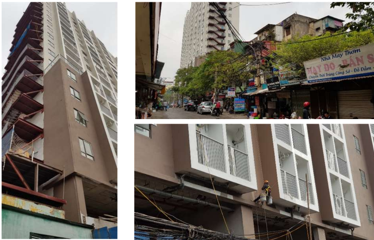
Hình 3: Dự án xây mới chung cư C1 thuộc khu tập thể Thành Công Đây là dự án được xây dựng thay thế cho nhà tập thể cũ C1 Thành Công cũ nát và xuống cấp nghiêm trọng trước đó.
